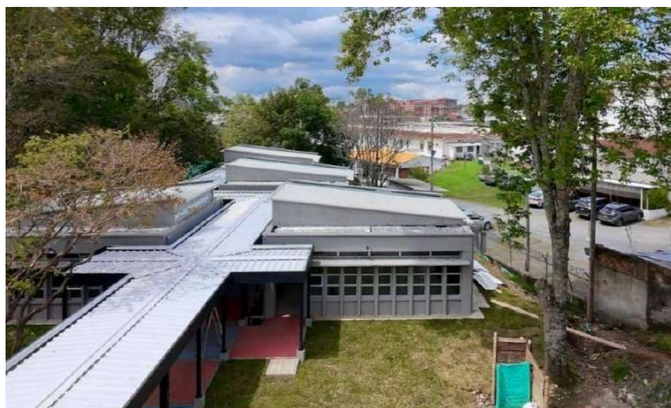
Figura 53. Vista aérea Aulas Amigables.
